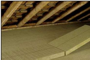
Die Wärmedämmung der obersten Geschossdecke ist immer dann richtig, wenn der darüber befindliche Dachraum nicht beheizt wird. Prinzipiell kann man die Decke von oben, aber auch von unten, also von der Raumseite aus, dämmen. Der Dämmstoff sollte möglichst dicht, ohne Unterlüftung an der zu dämmenden Decke anliegen.
