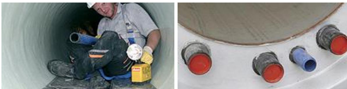
Abb. 102: Wärmetauscher: Nachträglich als Edelstahlelement oder beim Bau integriert
