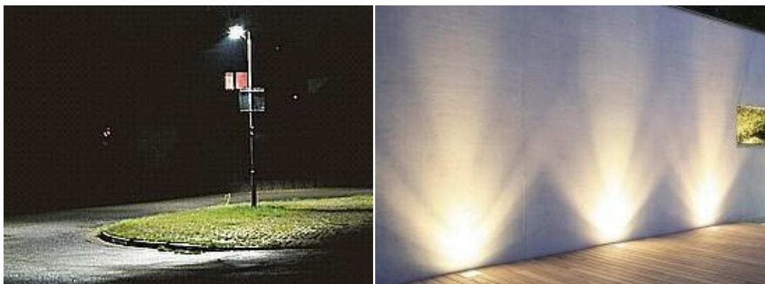
Abb. 31: Direktstrahlende Kofferleuchte (links) und Aufstreuende Dekorativ-Leuchten (rechts)<sup>6</sup>
