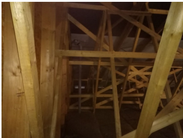
Abb. 3: Randbereich des Dachbodens.
