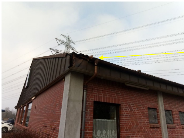
Abb. 5 a und b: Eine Kante des Dachbereichs wurde in der Vergangenheit mehrfach durch LKWs beschädigt. An dieser Stelle besteht nun eine Einflugmöglichkeit in den Dachboden für Kleinvögel oder Fledermäuse.
