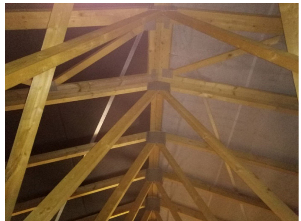
Abb. 4: Holzstreben im Giebelbereich des Dachbodens.
