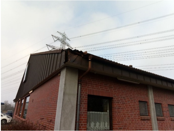
Abb. 6: Hinter der braunen Fassadenverkleidung im Giebelbereich besteht Quartierpotenzial für kleine Fledermausarten.
