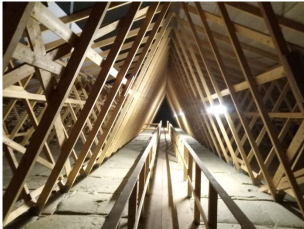
Abb. 1: Der Dachboden ist mittig über einen T-förmigen Holzsteg begehbar.
