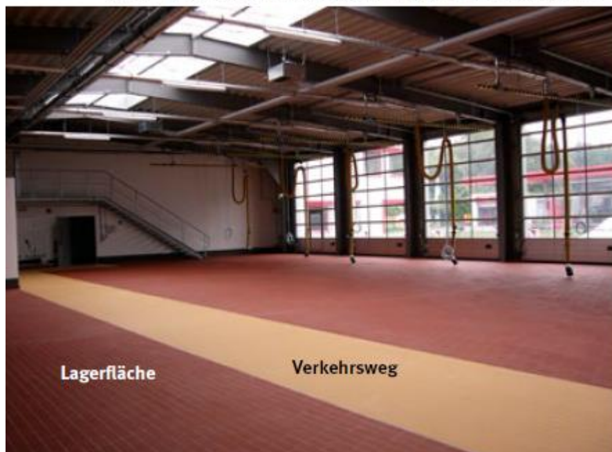
Bild 8 Farbliche Absetzung des Verkehrsweges in der Fahrzeughalle
