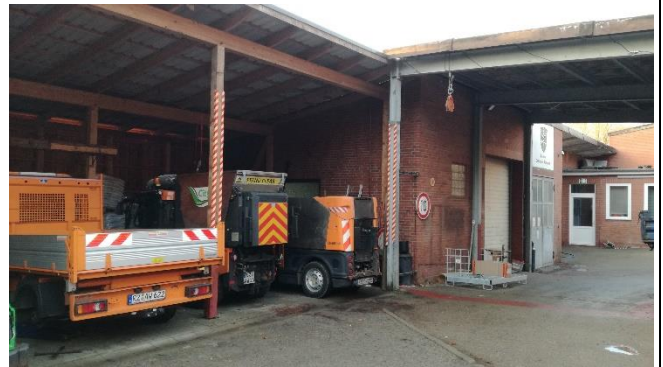
Foto 11: Abstellhallen der Gemeinde
