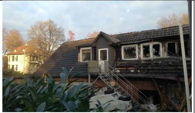
Foto 5: Brandruine aus westlicher Richtung fotografiert
