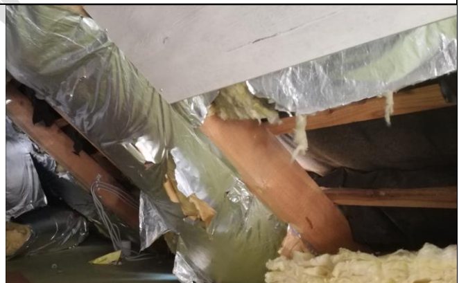
Foto 9: Dachdämmung Glaswolle, Plastik, wenig für Fledermäuse geeignet
