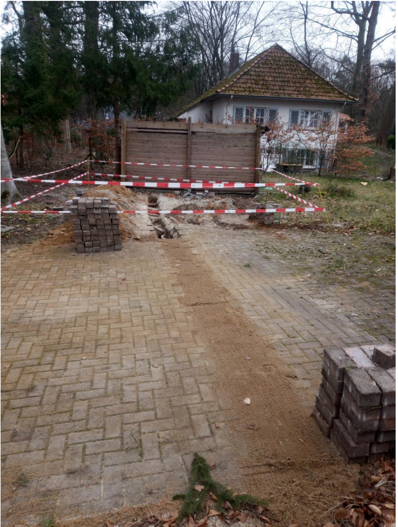
Abb.6: Übersicht der Wurzelgrabung am 20. März 2023. Lfdm 4-10 wurden verschlossen, die Wurzeln mit Juteumwicklung gesichert, s. auch Abb. 7
