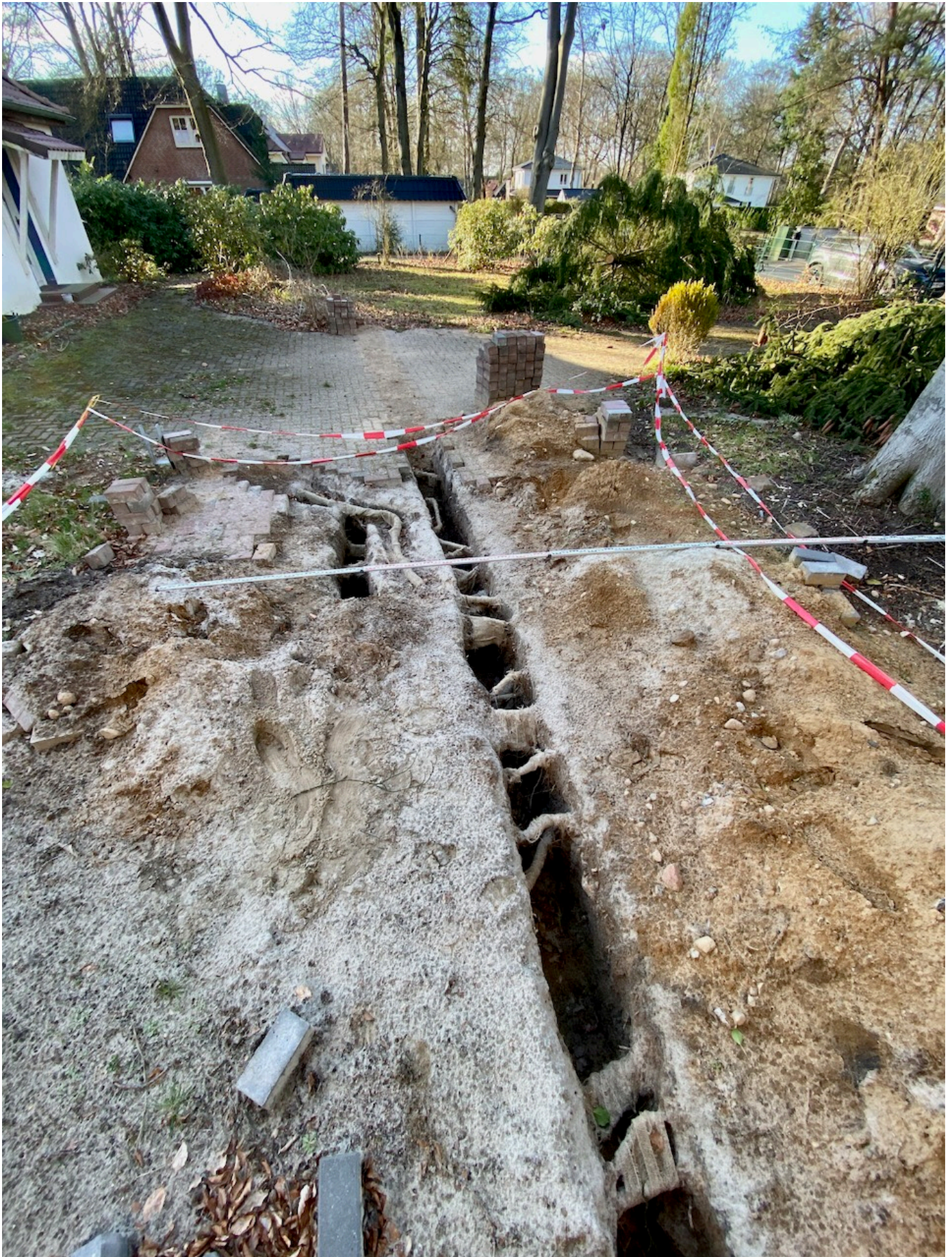
Abb.7: Sicherung der Wurzeln von Baum Nr. 1 mit Juteumwicklung (20. März 2023, Aufnahme am 4. April 2023)
