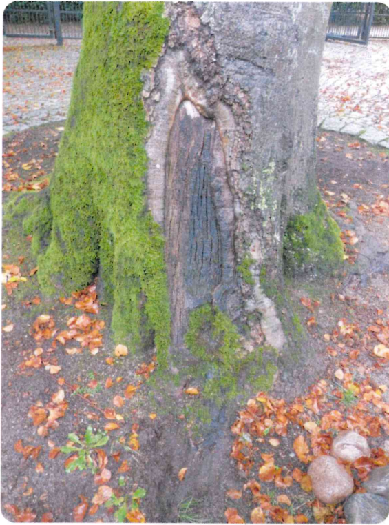
Abb.4: Schadstelle am südlichen Stammfuß
