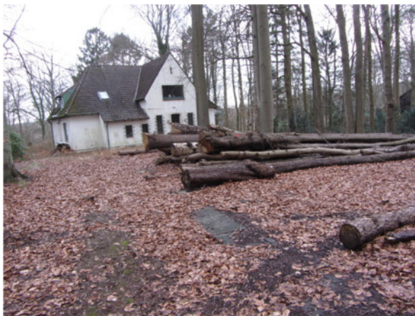
Foto 1: Eingangsseite des Haupthauses (Osten)
