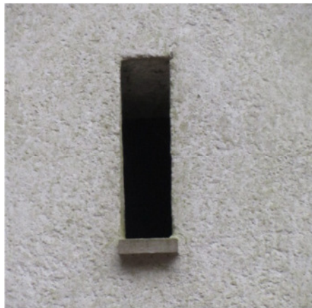
Foto 5: Öffnung (Lüftung?) an der Vorderseite des Garagengebäudes
