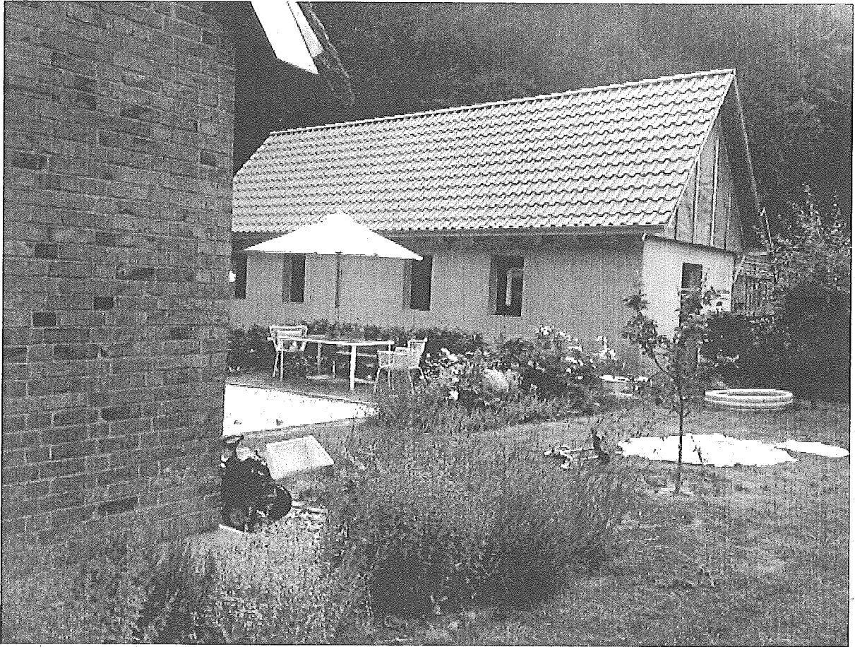
Aktuelle Ansicht des Gebäudes vom 22.06.2017
