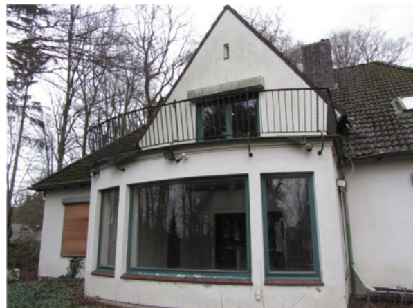
Foto 2: Gartenseite (Westen) des Haupthauses, Fenster z.T. mit Jalousienkästen
