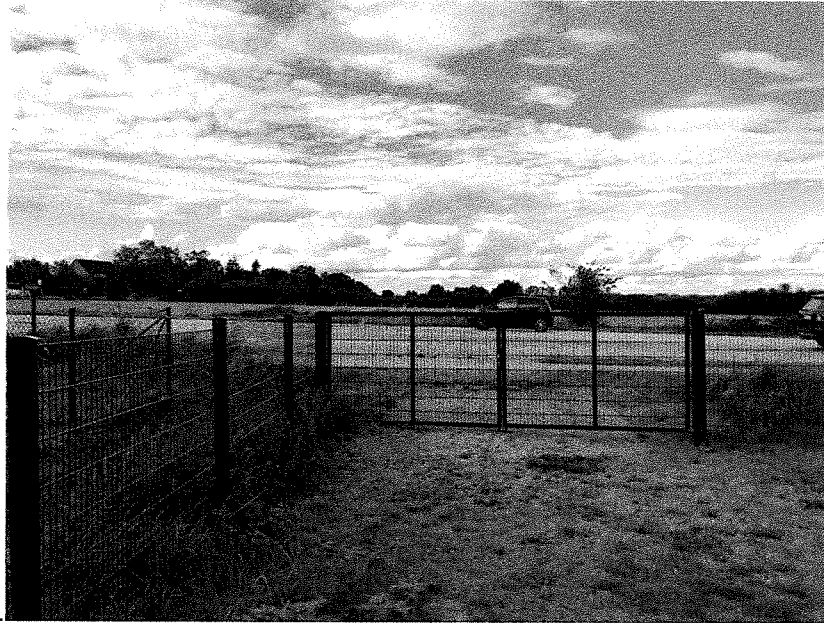
Bild 4: Blick auf das Tor der Abwasseranlage auf die B-207 / Zufahrt
