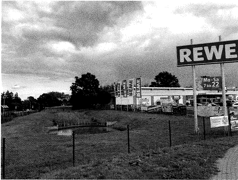
Bild 1: Blick in östliche Richtung auf das Rückhaltebecken (Rewe-Markt)
