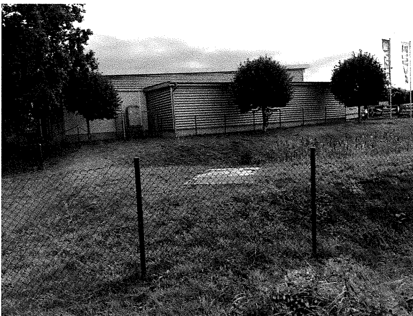
Bild 2: Blick auf das Ablaufbauwerk, im Hintergrund der vorhandene. Rewe-Markt)
