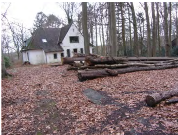
Foto 1: Eingangsseite des Haupthauses (Osten)
