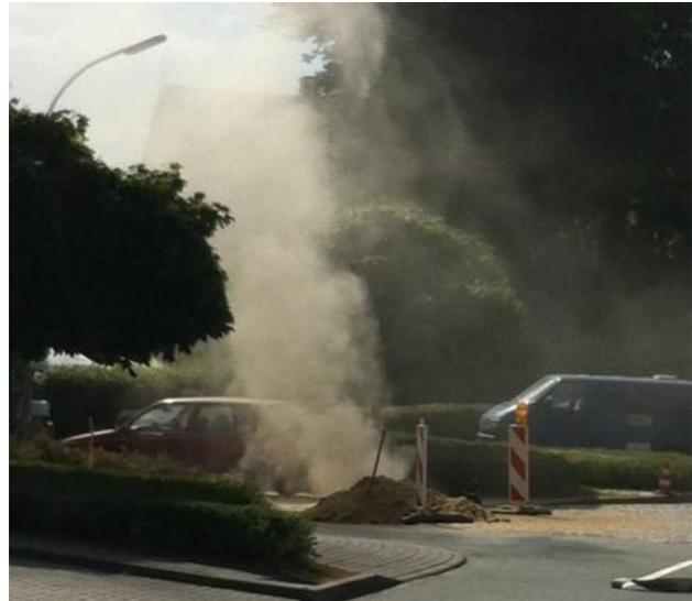
Am Vormittag des 5. September 2012 wurde eine Hochdruckgasleitung (ca. 15 bar Druck) bei Bauarbeiten beschädigt. Die Gemeindearbeiter wurden von den Bauarbeitern unmittelbar hinzugerufen und mussten vor Ort feststellen, dass Gas unter hohem Druck aus dem Boden strömte und dabei feinen Sand mit aufwirbelte. Eine di-
