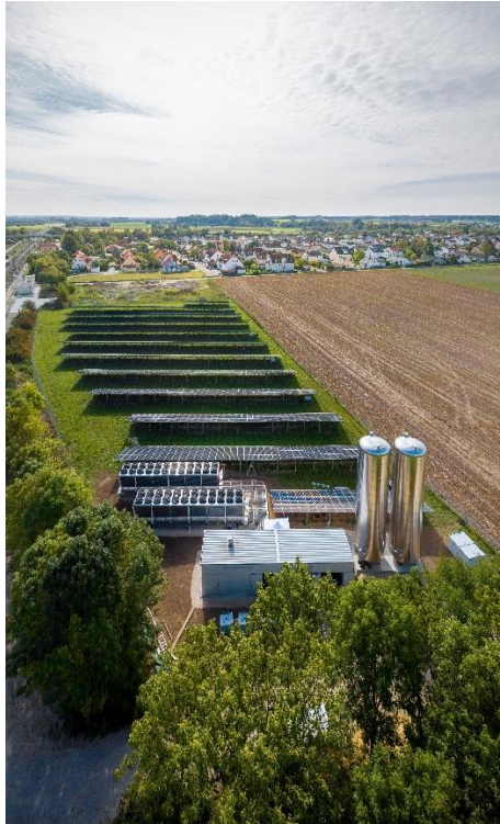
Abbildung 36: Heizzentrale eines auf einer Wärmepumpe basierenden Wärmenetzes (Mertingen, 2023)
