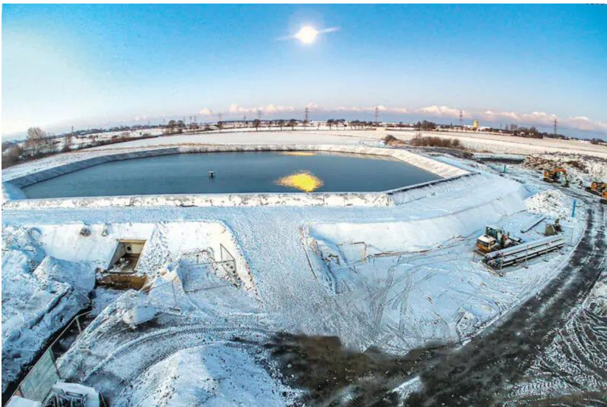
Abbildung 27: Saisonaler Wärmespeicher Meldorf
